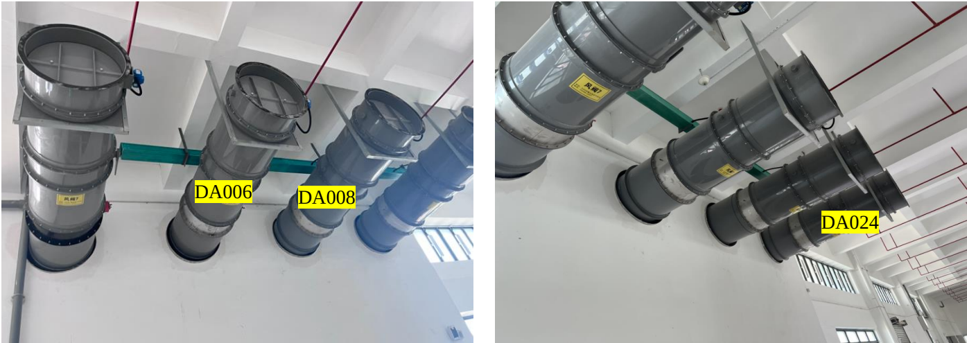
图 4-1 本项目与 1#厂房废气接收主管现状照片
