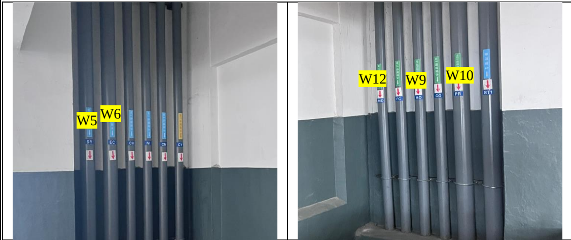
图 4-2 本项目所在 1#厂房 702 废水收集管道
