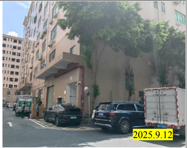
项目东面——A3 栋厂房
