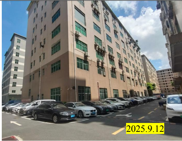
项目北面——B2 栋厂房
