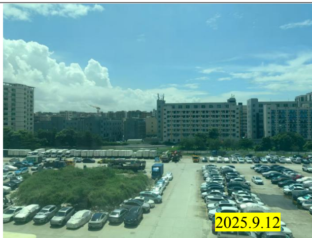
项目南面——停车场
